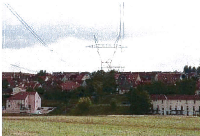
Ligne actuelle sous laquelle a été implantée une partie de trois lotissements de Louvres (source RTE)
